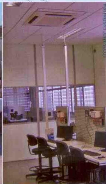
No hall do edifício, a alternativa foi a adoção de dois condicionadores tipo Splitão, cuja capacidade atinge 50TR, e que são distribuídos por dutos em formatos diferenciados e que garantem a climatização nas áreas comuns. “Contamos com a possibilidade de obter eficiência energética e um sistema inteligente com comandos remotos, tornando a instalação adequada ao destino final da unidade da Firjan” pontua.
